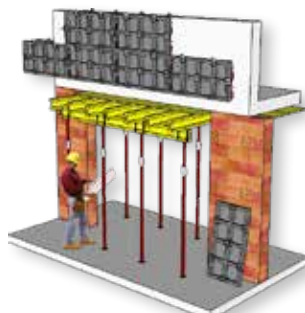
Opgegoten balken: afstellen van de betonrand + opgieten van betonbalk
